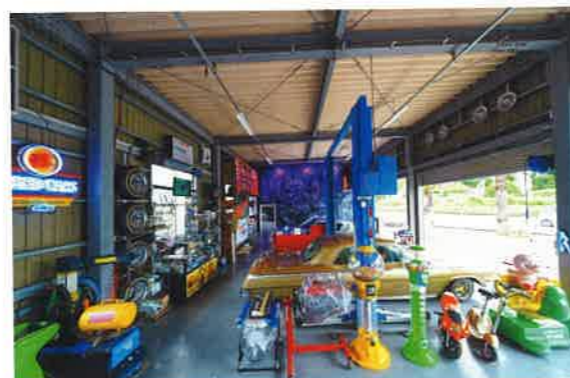
これだけ広々とした空間を作るには鉄骨造でなくてはならなかった。なお住居は本造で建てられており、アメリカンかつリゾートのようなスタイルで纏められている。
